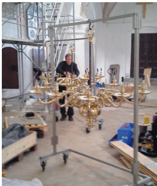
Alle lysekroner var nede til reparation, afstøvning og nylakering.
