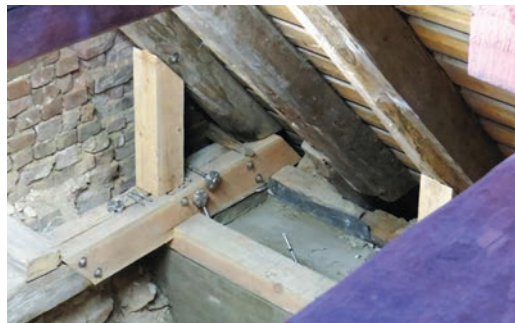
Spær og bindebjælker renoveret.
