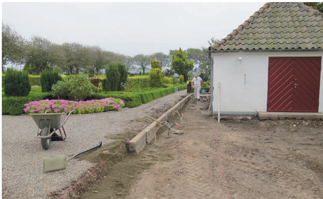
Bund og kantsten ved kapellet.
