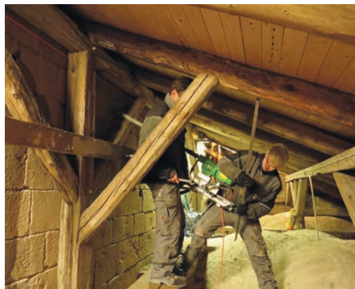
Tømrere i gang i loftsrummet.
