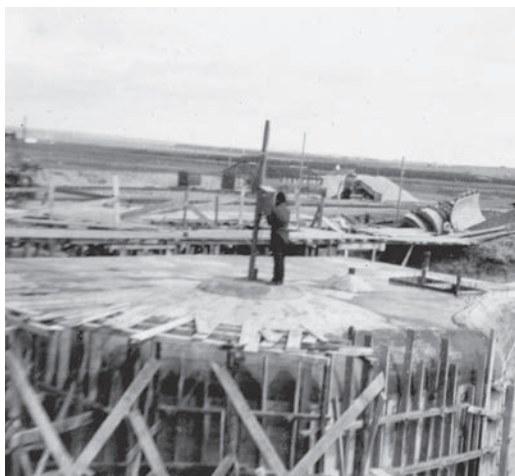
Bunker til M19-morter under bygning. Bunkeren er færdigstøbt, men hele forskallingen er endnu ikke fjernet. Efterfølgende blev der fyldt jord omkring bunkeren, så dets tag kom til at ligge helt plant med jordoverfladen. (Museumscenter Hanstholm).
