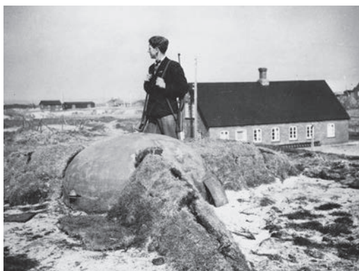
Panserkuppel i observationsbunkeren (Regelbau 666) i diget ved signalmasten. Græstørvene tjener til at sløre kuplens kontur, men er lagt i tre "strenger", så de ikke dækker observationsåbningerne i tårnets side. Der var desuden et hul i toppen af kuplen til et periskop. (Lokalhistorisk Arkiv for Thisted Kommune, 4610).
