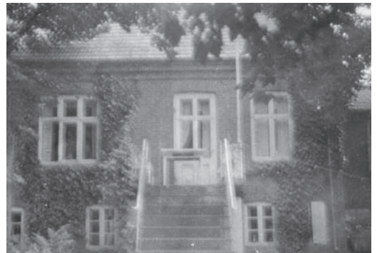
Huset fra havesiden.
