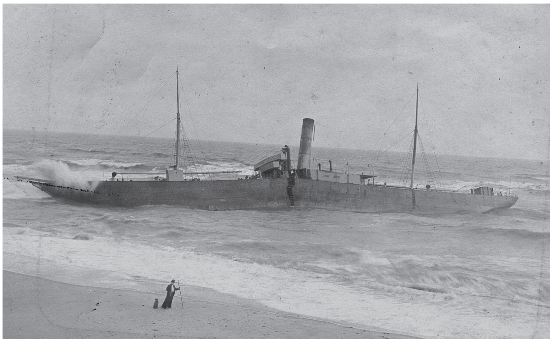
Havets kræfter fik det grundstødte skib til at knække midt over
