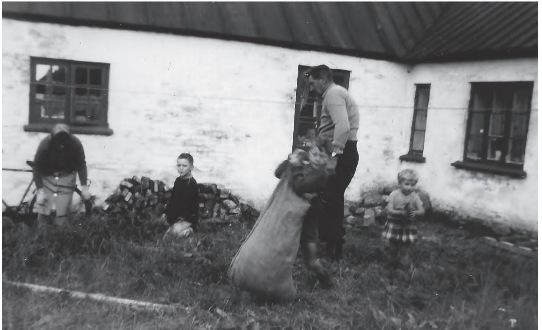
Vinduet til højre er ind til aftægtsstuen, det smalle vindue ind til gangen med de fem døre
