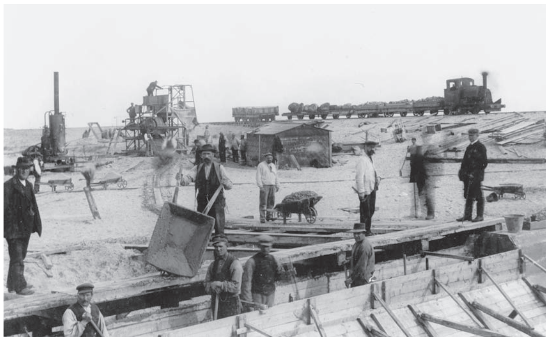
Betonstøbning ved høfde 85
