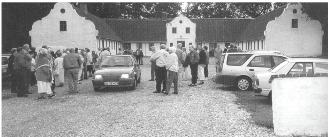
Ølands hovedbygning fra gårdspladsen.
