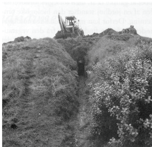
Fig. 4. I et forsøg på at forebygge nedsivende vand i kammeret blev højens øverste muldlag fjernet med gravemaskine. Derefter blev en vandafvisende lermembran lagt på og jorden ført tilbage. Foto Torben Dehn.
