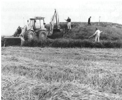
Fig. 1. Lundehøj under arbejdet i 1993. Med gravemaskine genåbnedes den store indgravning fra 1837 for at give mulighed for at se jordbøjens opbygning omkring jættestuekammeret. Foto Lars Holten.
