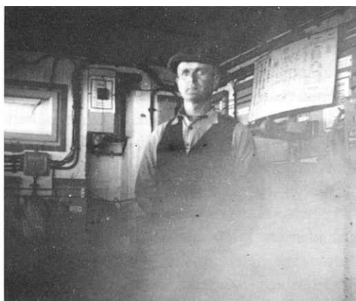
Observationsrummet i kommandobunkeren, fotograferet efter befrielsen men før de senere ødelæggelser. Man får her tydeligt indtryk af, hvor tæt pakket batteriets nervecenter var med elektriske installationer, så kommandanten herfra stod i direkte forbindelse med batteriområdets underlagte grupper, samt med divisionens hovedkvarter.
