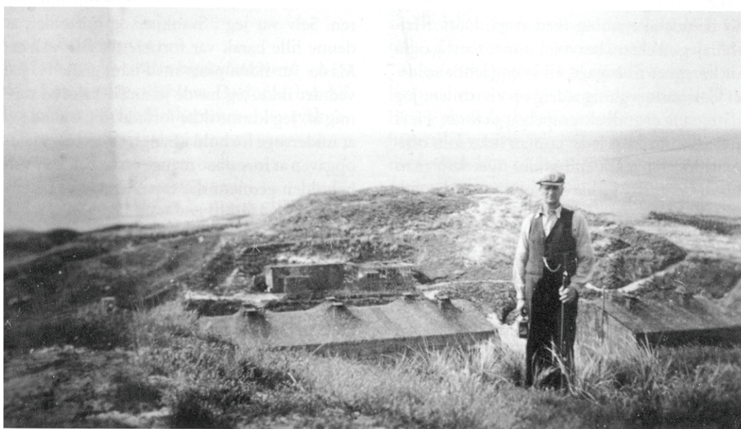
Udsigten fra kommandobunkeren. Thomas Eriksen på vagt i området, hvor slørede mandskabsbarakker ligger i læ bag den yderste klitrække.
