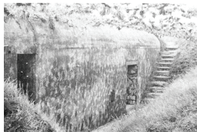
Nedgravet bunker under sløringsnet.
