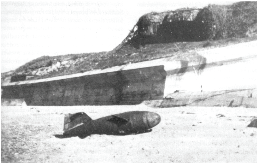
Lav betonmur til kystsikring af kassestat for 105 mm kanon. På stranden ligger en »Paravane«-minesporer.
