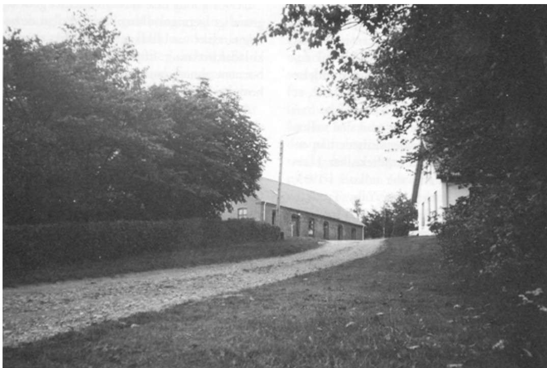
Til venstre: Ydby Missionshus. Huset til højre, er det der blev bygget af fru Svarre, og hvor N. M. Lauritsen havde tandklinik. Billedet er taget i 1992
