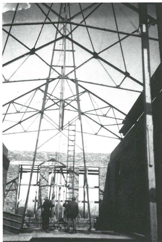
Til dette billede har Svend Dinsen denne forklaring: Det er taget i maj måned 1947. Jeg var dengang i lære hos maskinfabrikant Johannes Klausen, som havde kontrakten på fremstilling og opsætning af stålspærene på Hurup Elværks maskinhal. Vi havde hele måneden det prægtigste vejr, og vi kravlede rundt på spærene som havde vi været abekatte – og uden sikkerhedssele. Man havde ikke byggekraner. Konstruktionen, som rager op, er den »byggekran« som vi brugte til at løfte spærene op med, og som vi selv havde fremstillet.
