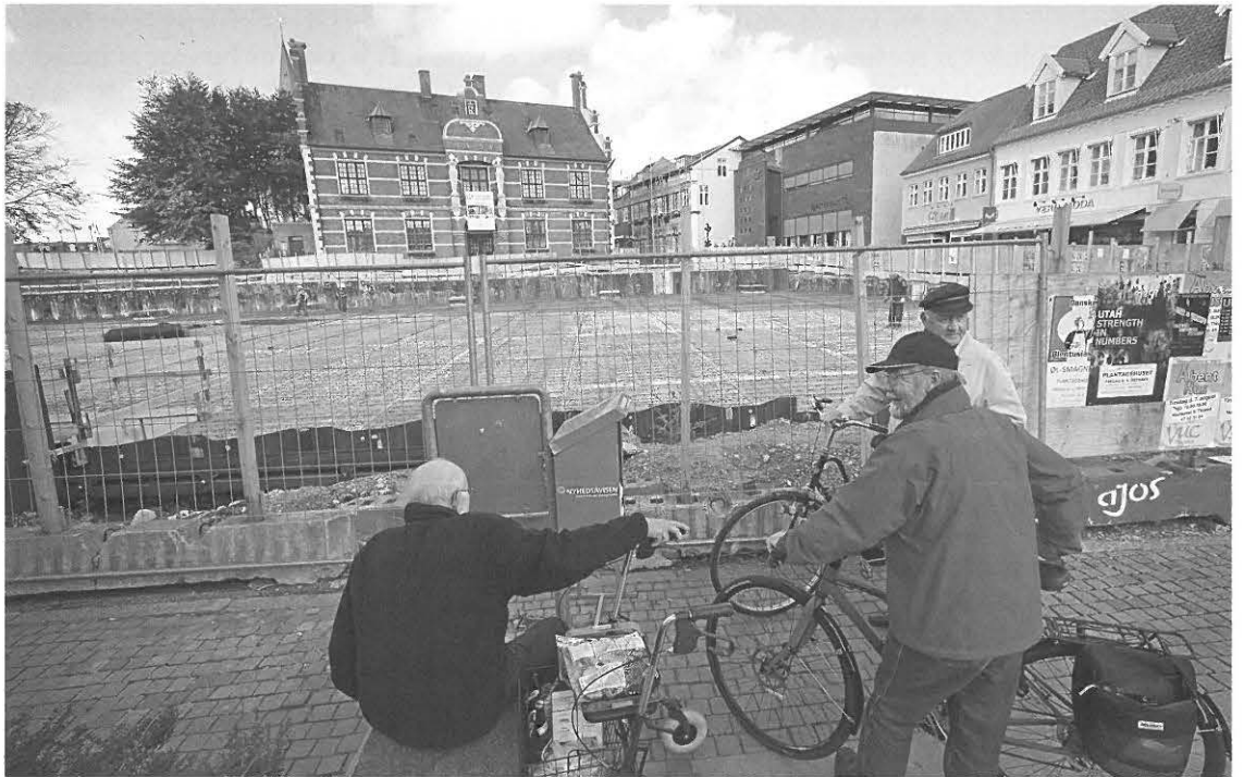
Fra byggepladsen ved Store Torv.
