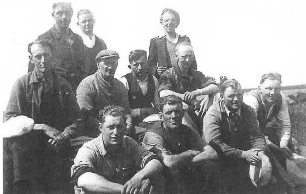
Søren Sørensen, Ellekrogen 28, Vedbæk, har sendt flere billeder fra Thisted 1940-50. Hans far, Gunnar Carl Sørensen, sidder som nr. 2 fra højre. Sjakket er sandsynligvis i færd med at grøfte på Aalborgvej. Det var muligvis det sjak, der lavede vejkrydset Østerbakken-Aalborgvej-Fårtoftvej-Vegendalvej i 1950. Nogle af folkene er gengangere fra Gulftanken. Søren Sørensen fik læreruddannelse, blev skoleinspektør og undervisningsinspektør i undervisningsministeriet. Siden 1995 har han navnlig forsket i den nordiske historie og været meget aktiv inden for Foreningen Norden. Han har hentet inspiration i Thy til flere af sine romaner og skrevet digte på thybomål.
