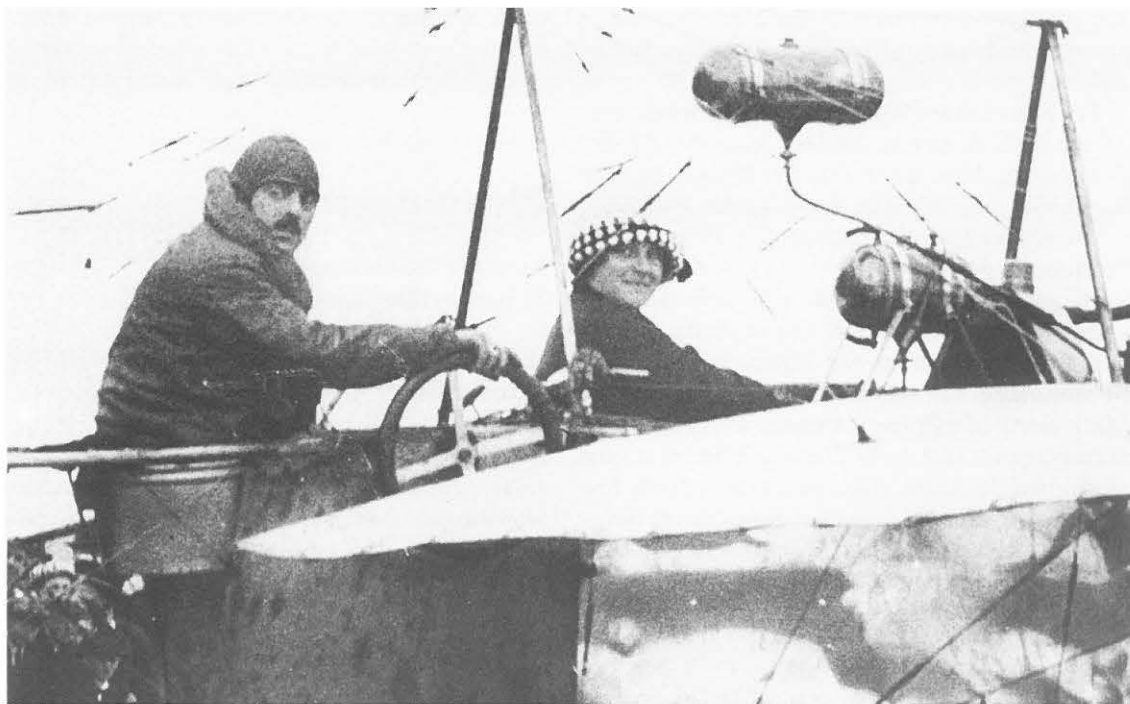
Poulain og hustru ombord i flyvemaskinen. Bemærk de små benzin- og olietanke.
