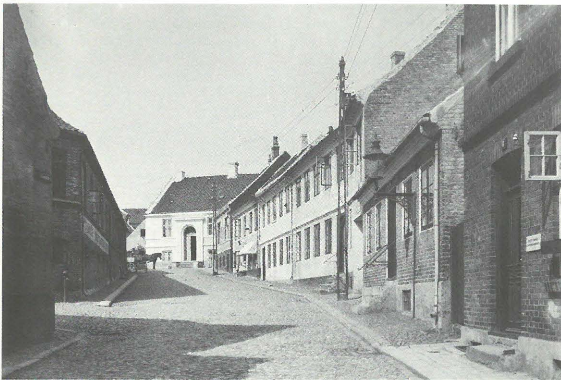
I forgrunden til højre ses nr. 8 med opgangen til vor lejlighed. Det åbne vindue er en af Nissens stuer.
