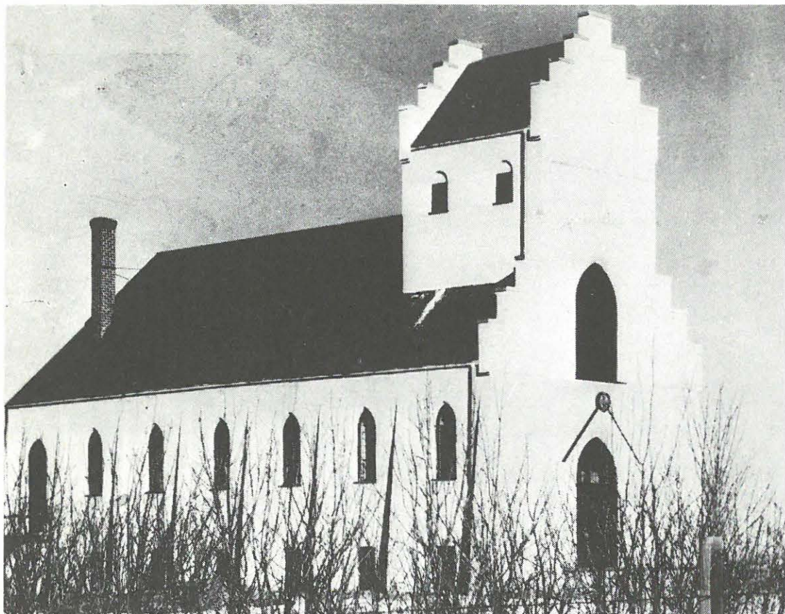
Dansk byggeskik er bevaret ved opførelse af kirker.
