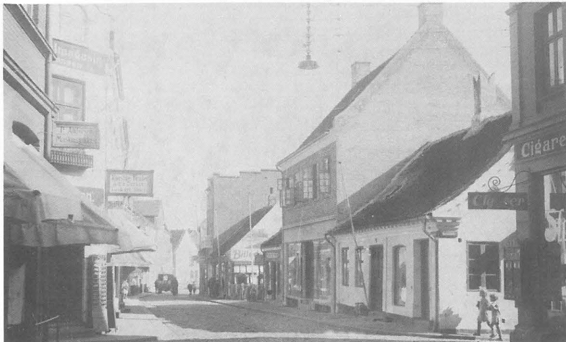
1928 blev der bygget en etage på huset i Storegade 14.
