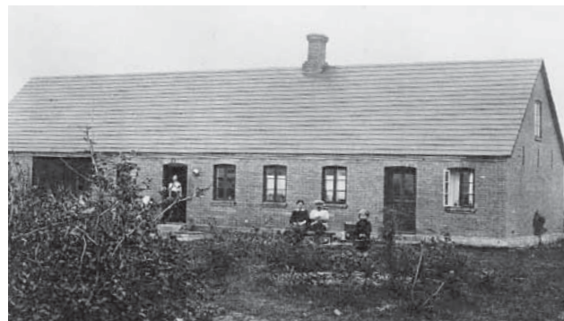
Ejendommen, matrikelnummer 1a1, Vesløsgård, udstykket af Carl Nørgård 1906. Foran den daværende ejer gartner Guttorm Thomsen og bustru Helga med datteren Inger, ca. 1910.
