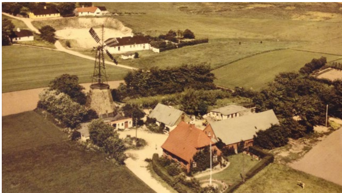
Billedet viser møllen ca. 1952 med klapsejlene på. Denne vindmotor havde erstattet de store vinger. Dette billede viser møllen blot et par år før denne klapsejlsmotor blev nedtaget. Nu kunne man klare sig med el-og oliemotorer.
