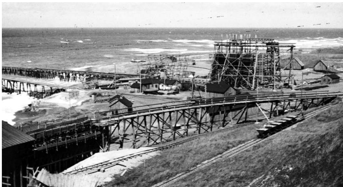
Hanstholm Havn i midten af 1930'erne med sænkekasser under bygning.
