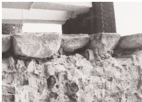
Kvadre under nedtagning med bagmur af munkesten.
