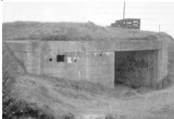
Prototype af tyskernes "Wassermann S". Bunker blev bygget i Vorupør og betjent af radarspecialister fra et forskningscenter i Kötchen. (ca. 1.400 m 3 jernbeton). Foto: Morten Binderup, 1991.
