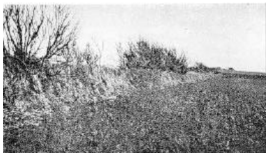
Jorddige uden grøft Foto: E. Foged.
