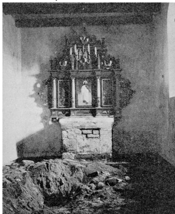
Fra Visby Kirkes Restaurering. Alteret med Esaias Klaumanns Grav.
